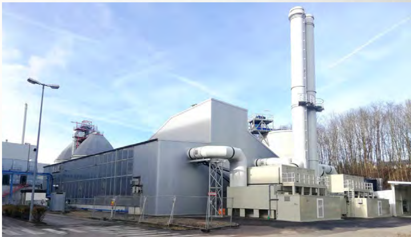
项目地：Sewage sludge drying, 德国 | 型号：2x BTU 1/6200-36 | 安装年份：2020 干燥物料：市政污泥 | 蒸发量：12.5吨/小时
